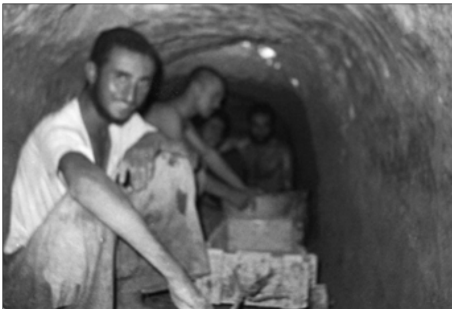
تابستان ۱۳۶۰، بچه‌های نجف‌آباد در حال حفر تونل اول، نفر دوم آزاده قربانعلی صادقی
