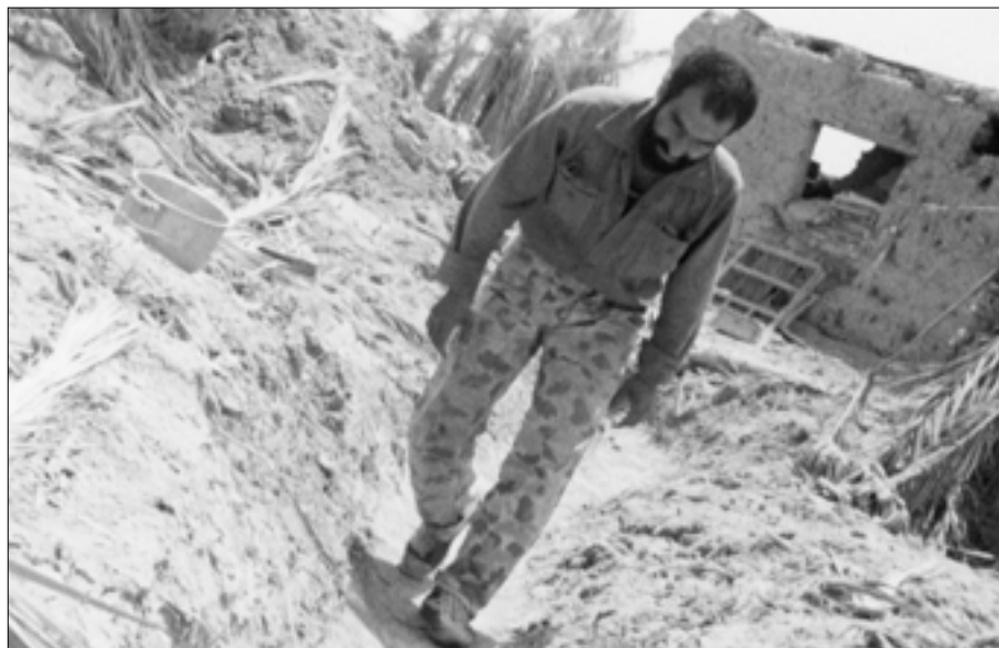
تابستان ۱۳۶۰، برای در امان بودن از تیر دشمن، در مسیر بین پاسگاه‌ها کانال احداث شد. سردار شهید حسنعلی یوسفان در حین عبور از داخل کانال حفر شده بین پاسگاه‌ها.
